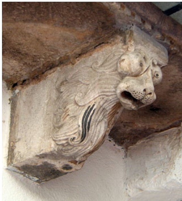
13. Senj, konzola lavljeg dvora, (foto: D. Krizmanić)
