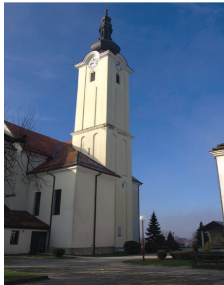
Slika 3. Crkva sv. Marije, pogled sa sjeveroistoka.
