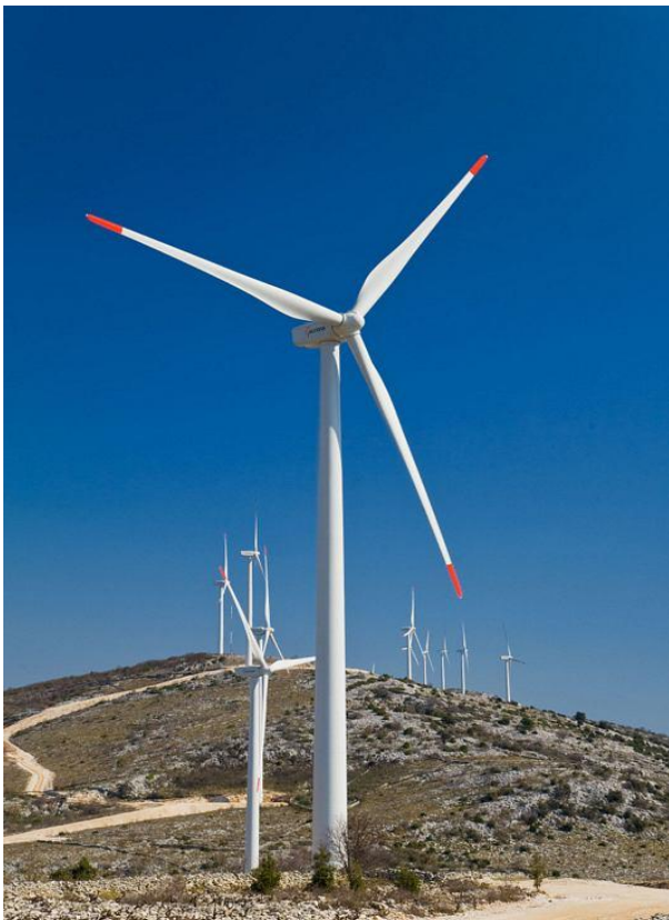
Slika 12. Vjetroagregat s vodoravnom osi (Šibenik) [18].
