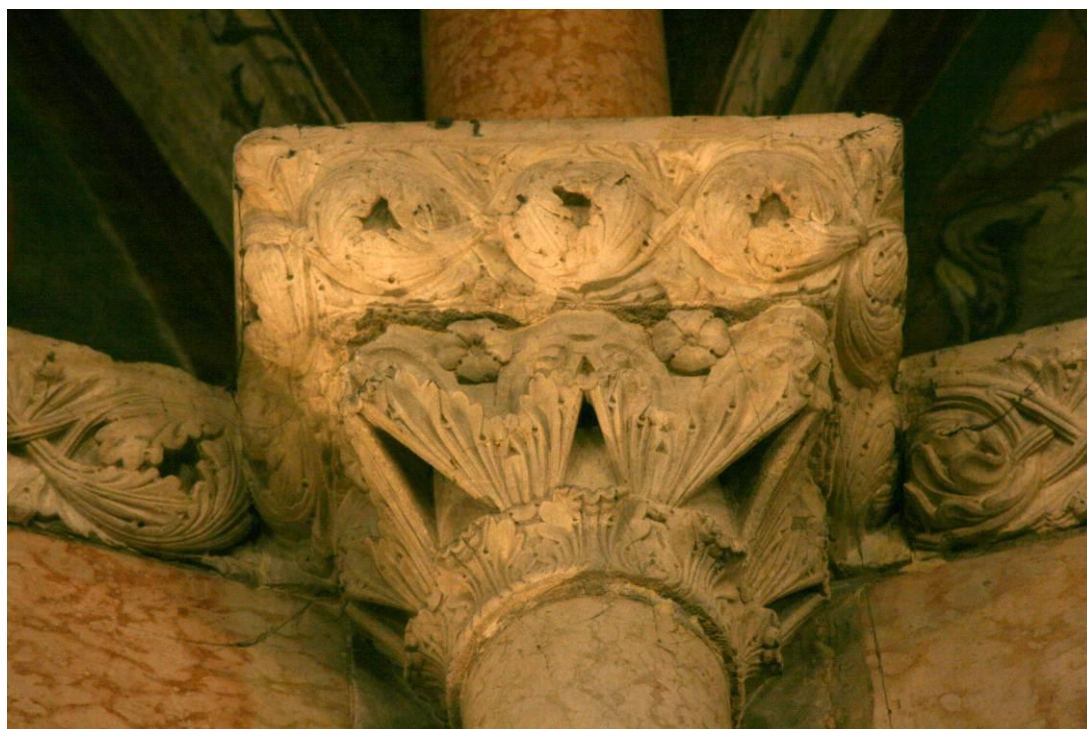
Fig. 2 Parma, Battistero, interno, capitello corinzio della cornice alla base della cupola.
