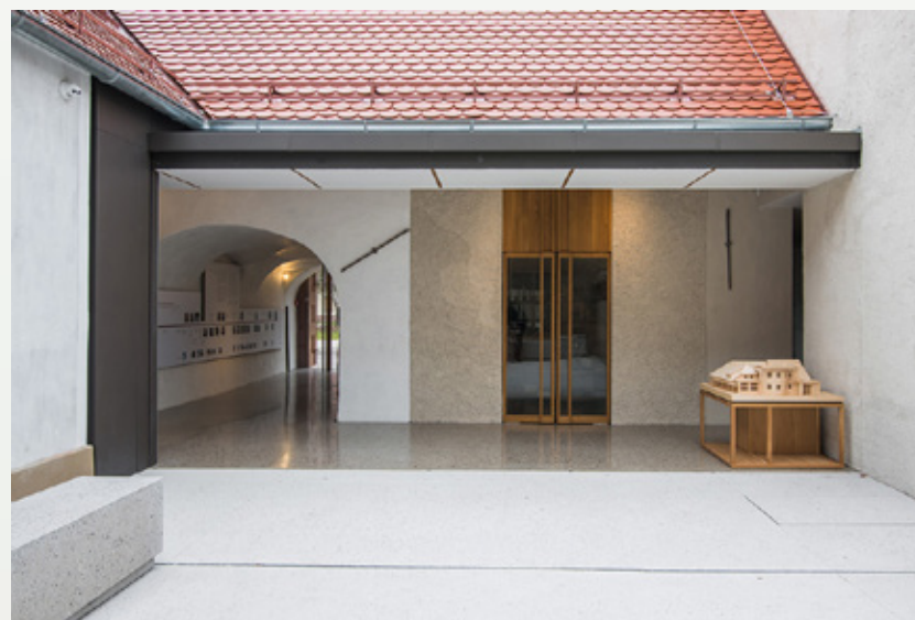
Plečnikova kuća, krilo prema Karunovoj ulici, stanje nakon obnove
