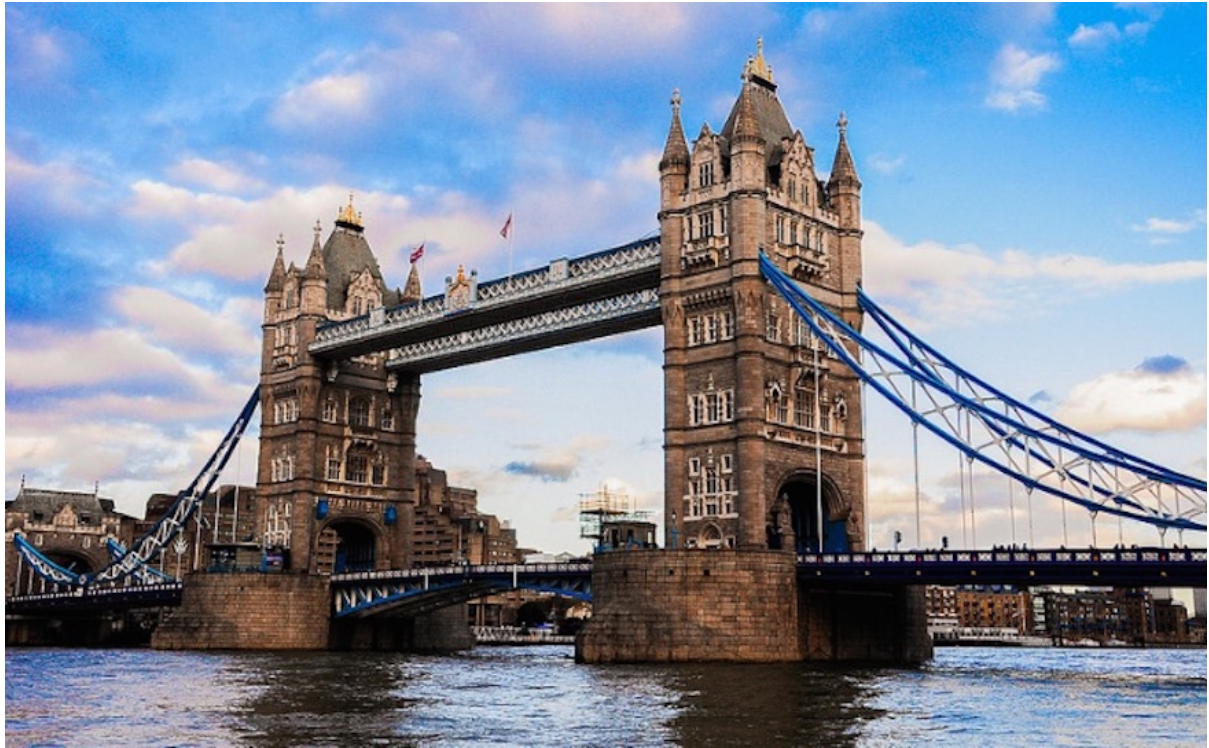
Slika 24: John Jackson, Tower bridge , 1884.-1894., London, Velika Britanija
