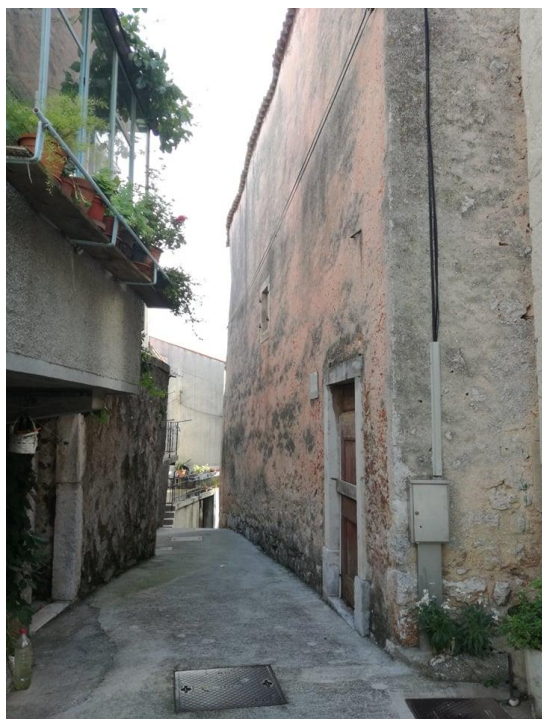
Slika 6. Zgrada „kašće“. Pogled s ulice, snimila: Iva Kuljiš, 2019.
