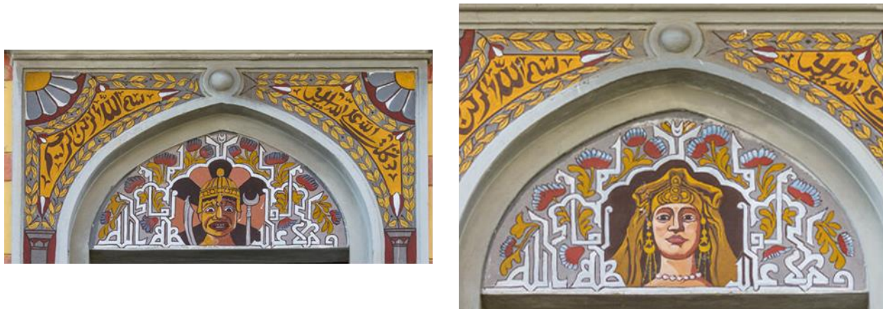
Fotografije 3 i 4: Detalj pročelja, Turska kuća, Rijeka, 1906.
