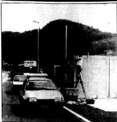
Postavljanje kontejnera - kućice u Dragonji, na slovenskoj strani granice
