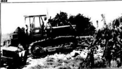
Kod mjesta Jeļšane su radovi u punom jeku, do 26. lipnja će sve biti gotovo
