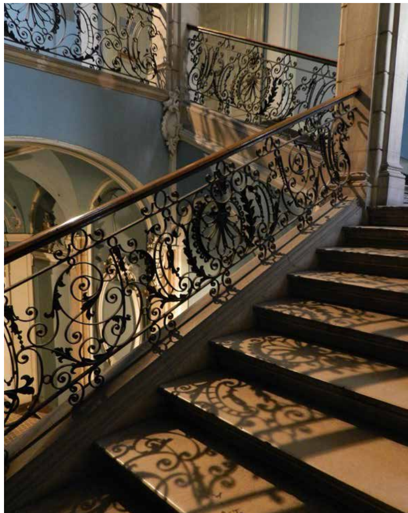
6 Palača Ploech, Rijeka, stubište
