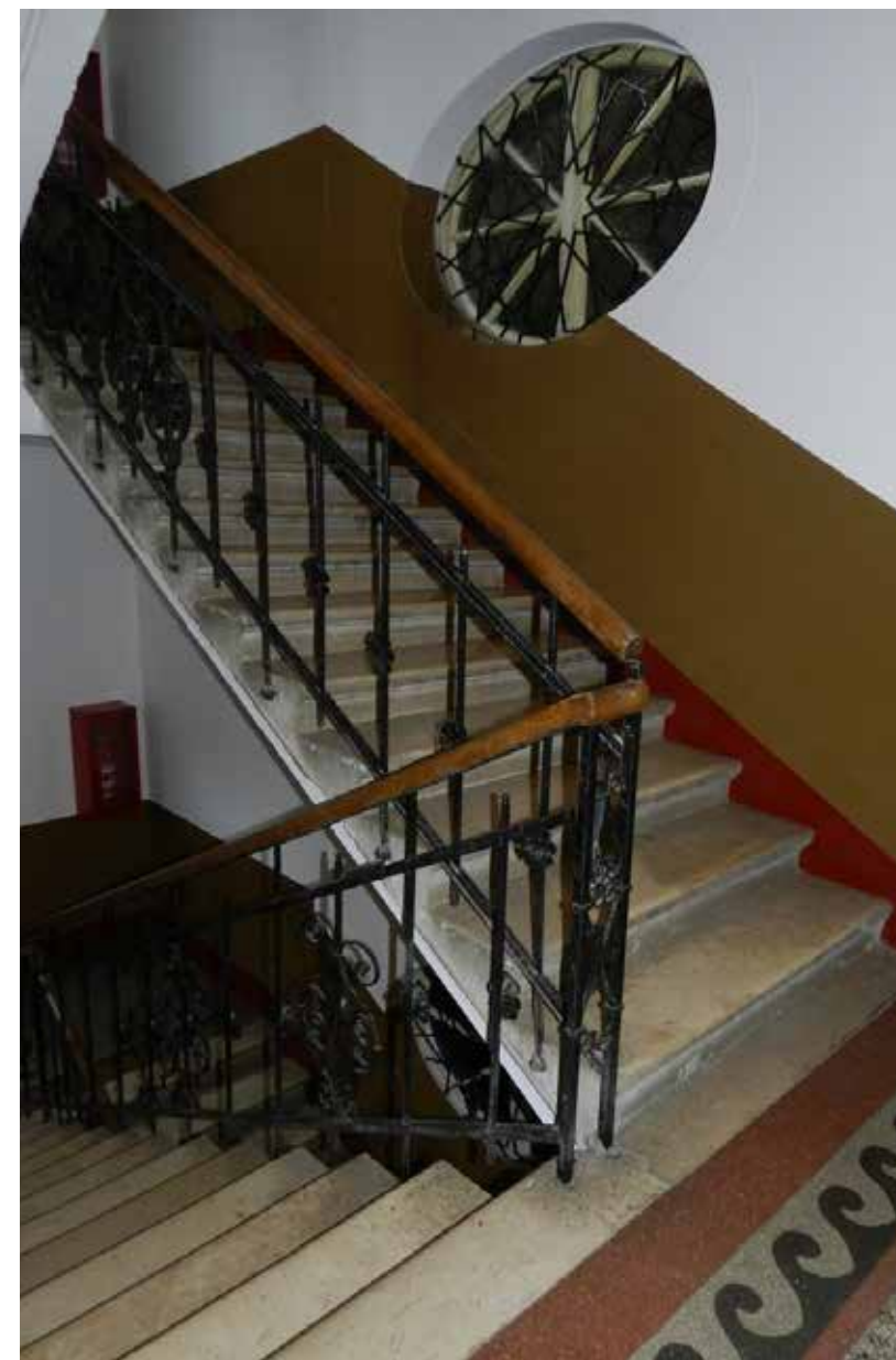
7 „Turska kuća“, Rijeka, stubište
