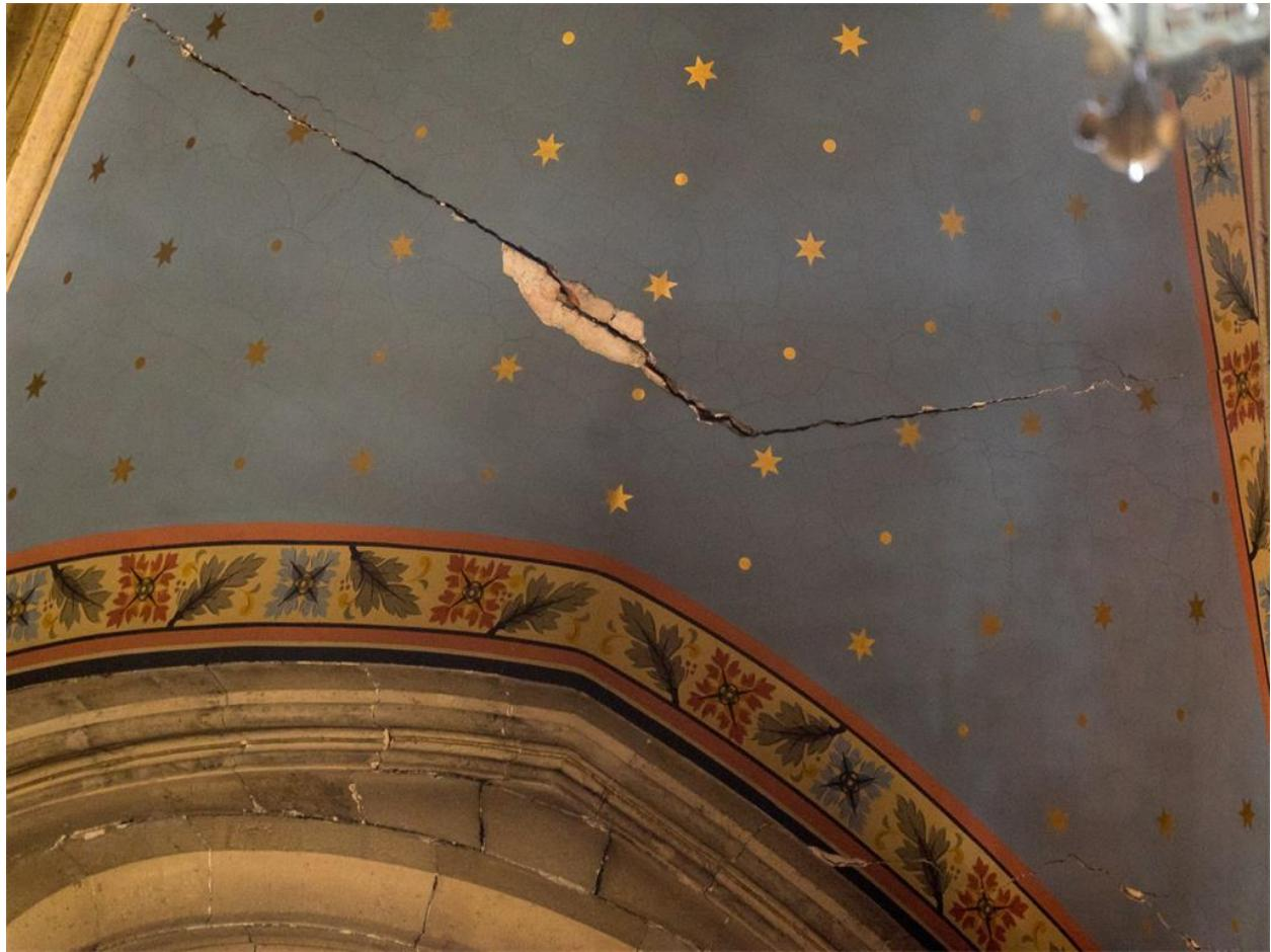
Slika 20: Prikaz oštećenja svoda
