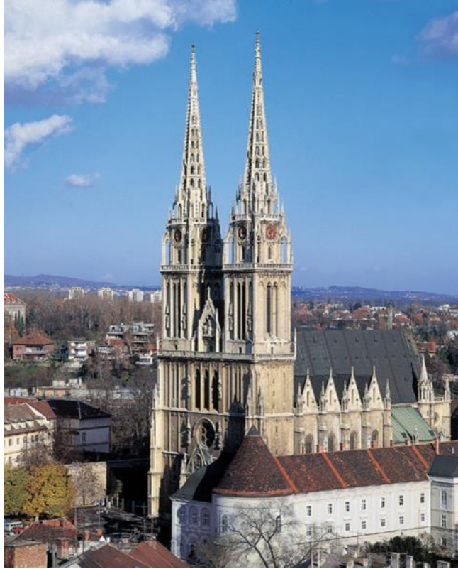
Slika 6: Zagrebačka katedrala- pročelje i sjeverni brod s kontraforima
