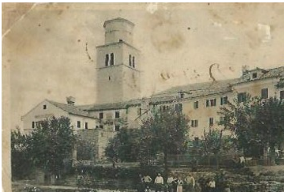
Sl. 24. Ožbukane kuće građene nad zapadnim potezom zidina, Zavičajna zbirka Enriko Depiera, 1899.
