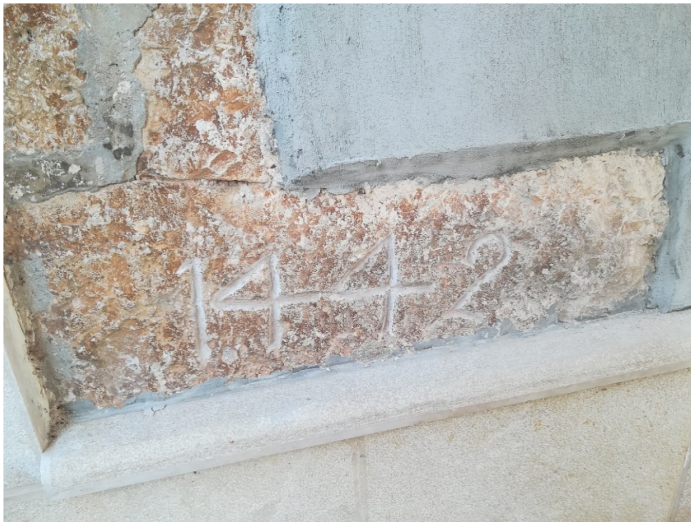
Sl. 30. Kameni kvadar s uklesanom godinom izgradnje tzv. renesansne kuće, 1442.
