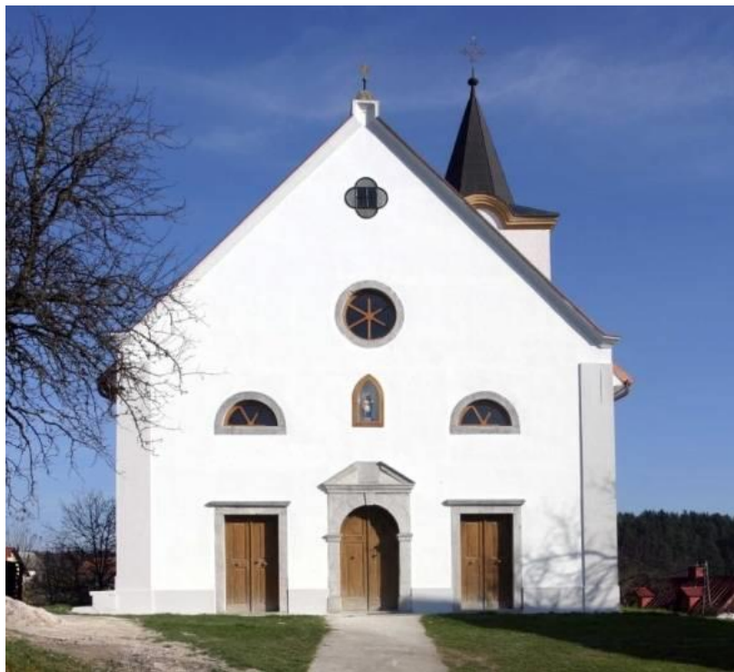
Slika 6. Pročelje crkve sv. Nikole, Brod Moravice (FOTO: Damir Krizmanić)
