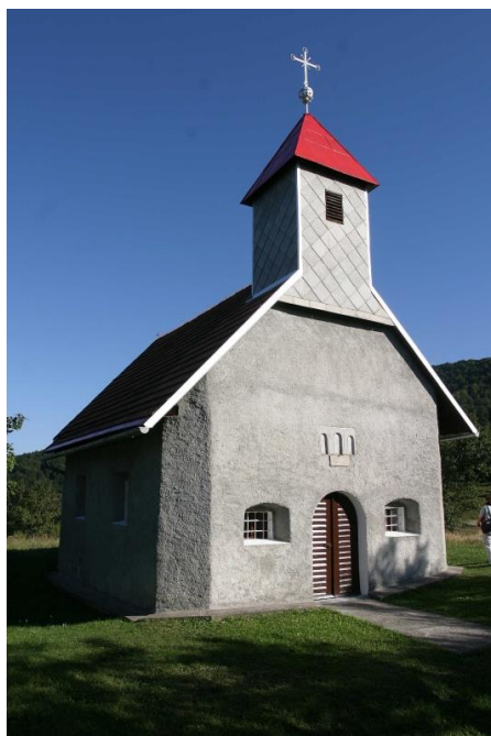
Slika 32. Crkva sv. Josipa, Stari Lazi (FOTO: Damir Krizmanić)
