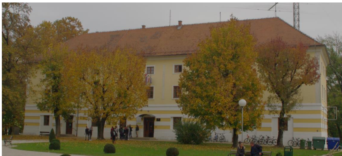
Slika 57: Dvorac Batthyány, istočna gospodarska zgrada
