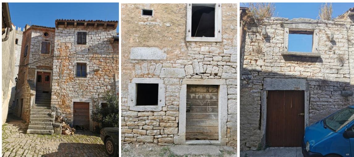
Slika 28., 29. i 30. Zapadna fasada kuće uz crkvu sv. Martina, sjeverna fasada kuće uz crkvu sv. Martina i istočna fasada kuće na k.č. 12, snimila Irena Radoslav 2021.
