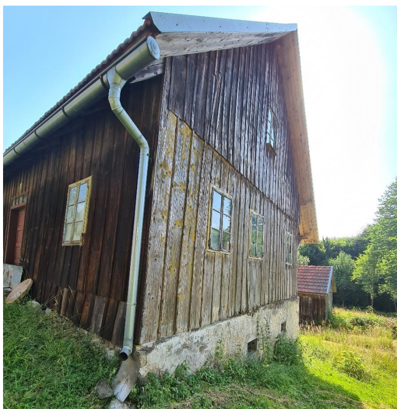
Slika 23. Kuća na adresi broj 3 u Smišljaku, pogled na frontalni i zabatni dio (Foto: Katarina Tušek)
