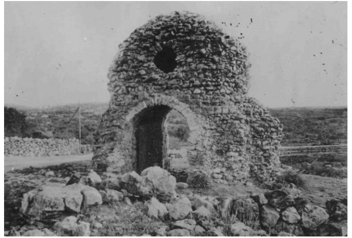
Slika 6. Crkva sv. Donata pokraj Punta prije rekonstrukcijskih zahvata (izvor: Fototeka Konzervatorskog odjela u Rijeci)
