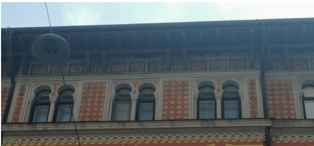
Slika 22. Detalj pročelja, bifore na potkrovnom dijelu, Turska kuća, 1906. g.
