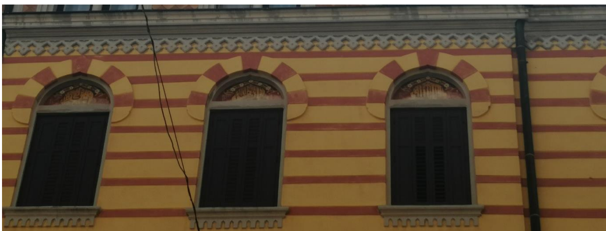
Slika 21: Detalj pročelja, lunete trećega kata, Turska kuća, 1906. g.
