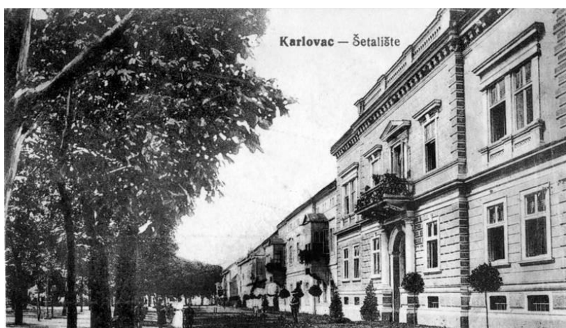
Slika 6. Kuća Ivana Banjavčića na Velikoj promenadi , snimljeno u prvoj polovici 19.st.
