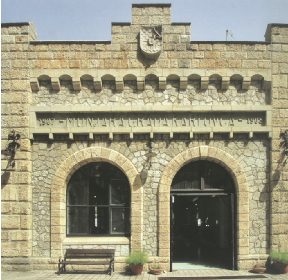
Slika 5. Pročelje pogonske zgrade Hidroelektrane Ozalj
