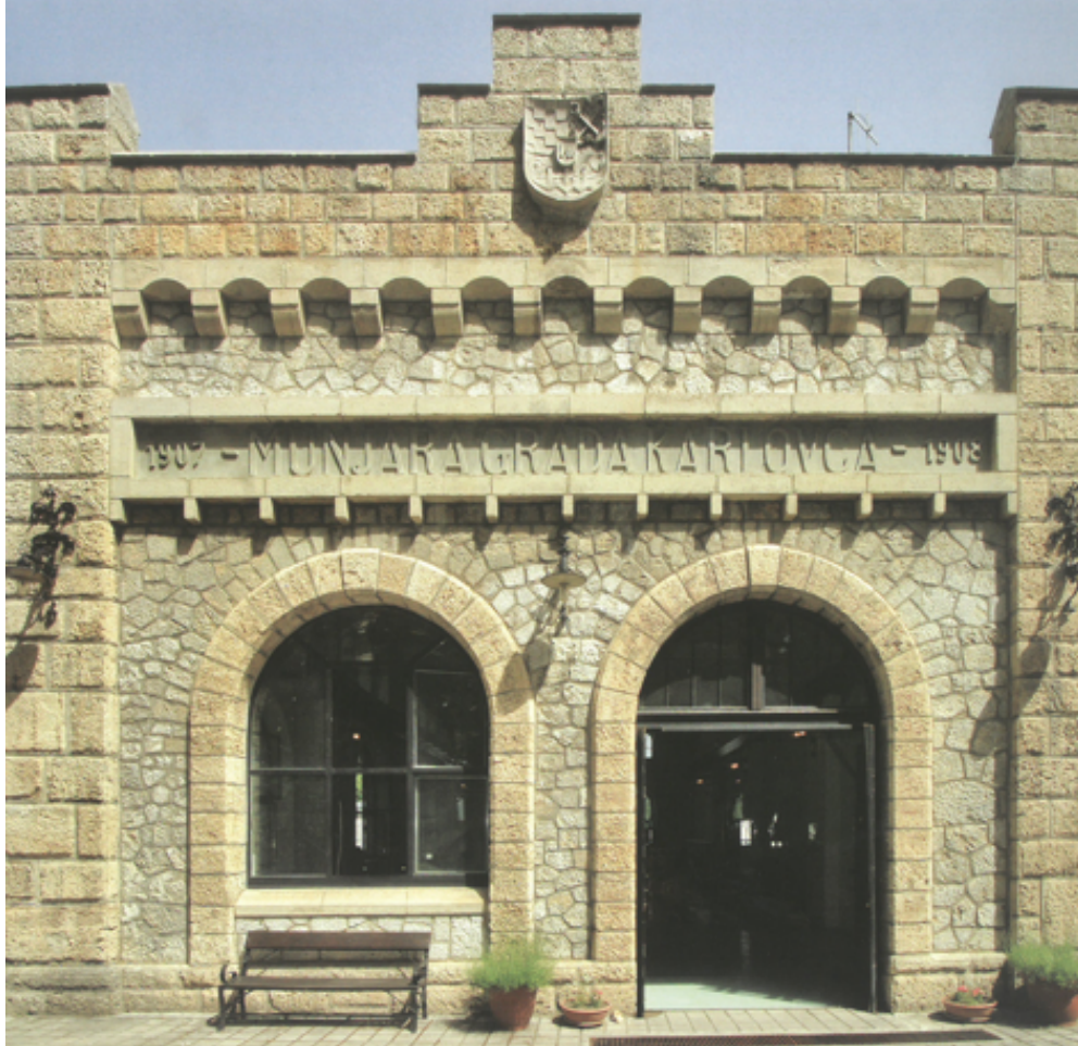
Slika 5. Pročelje pogonske zgrade Hidroelektrane Ozalj
