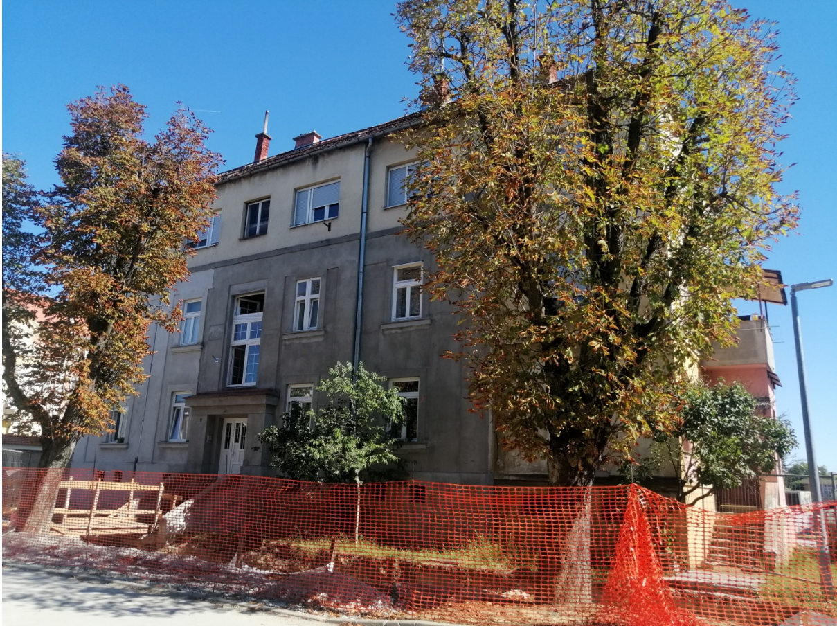
Slika 12. Događena stambena zgrada, zapadno pročelje, 2022.
