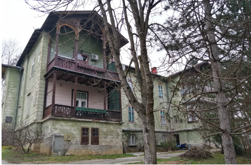
Slika 28. Direktorska vila unutar kompleksa nekadašnje tvornice, 2022.
