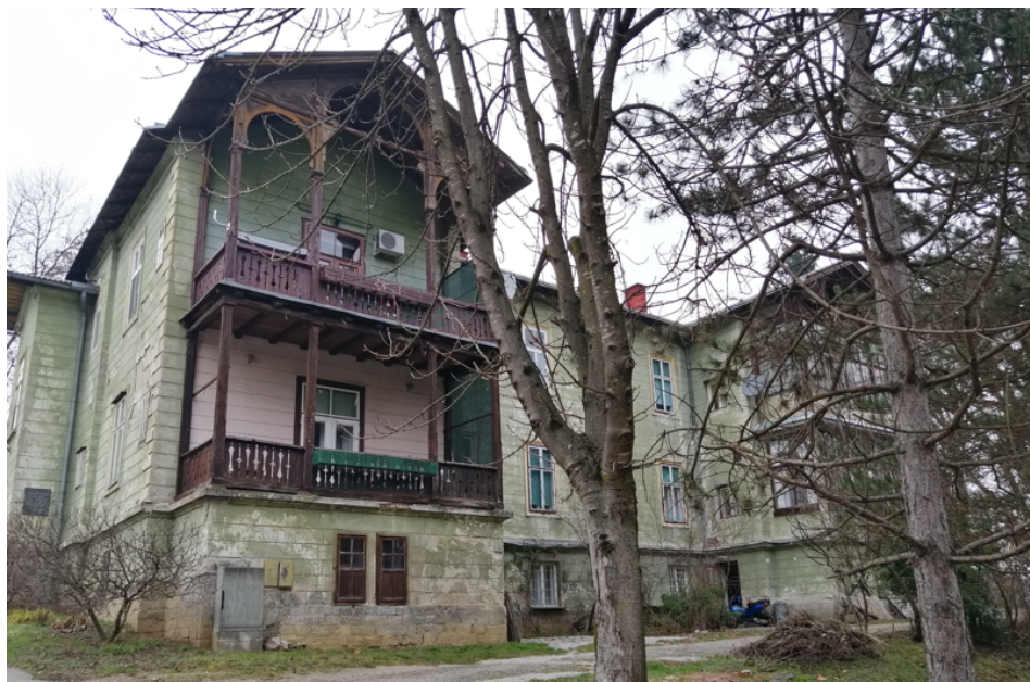
Slika 28. Direktorska vila unutar kompleksa nekadašnje tvornice, 2022.
