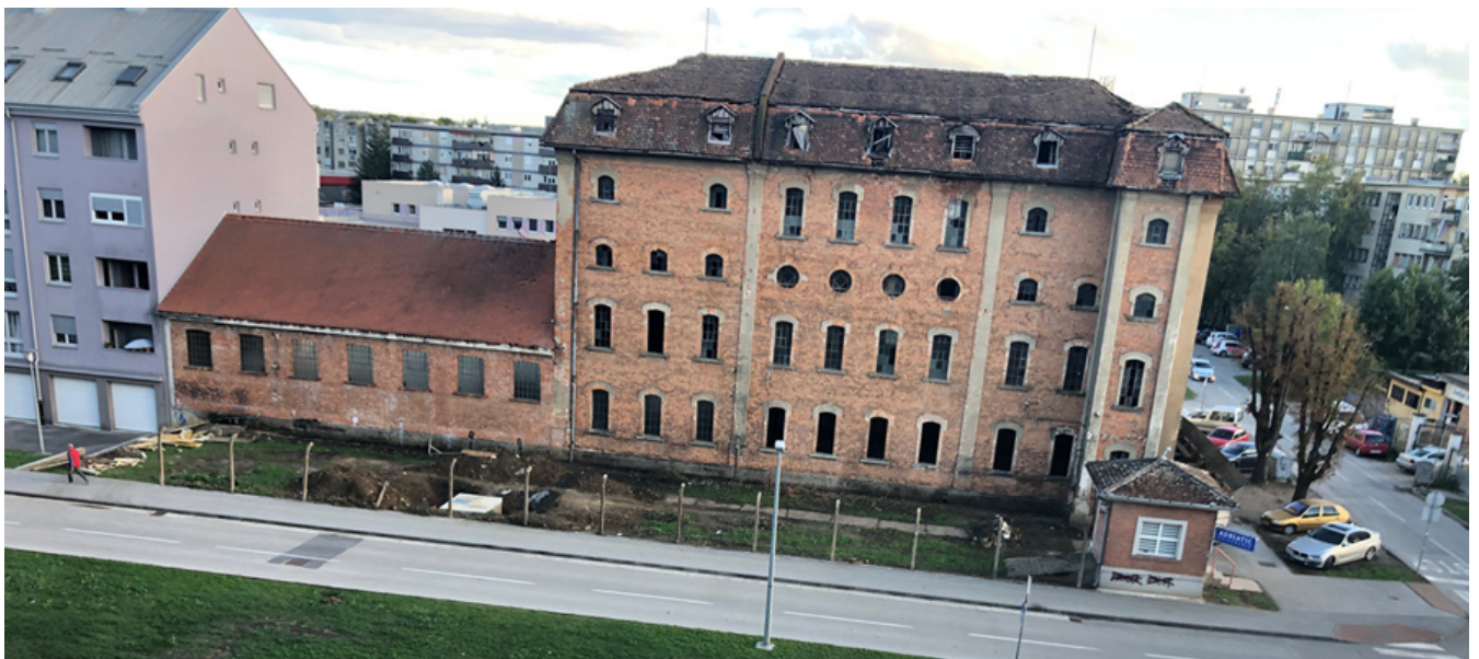
Slika 32. Stanje poslovne zgrade bivšeg Mustada prije obnove
