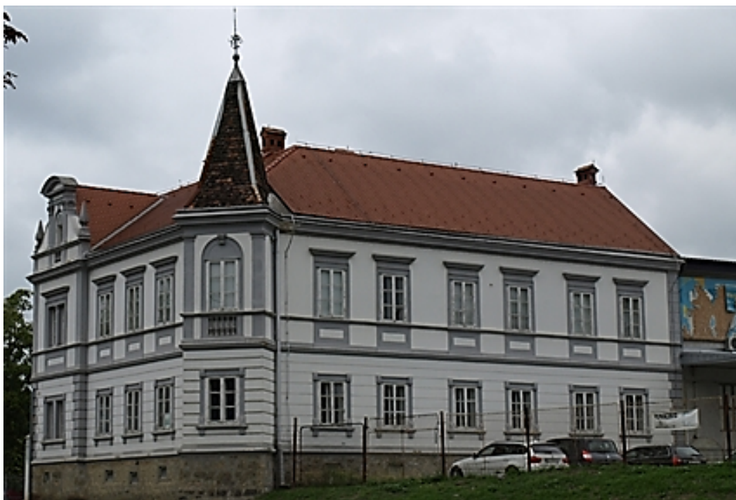
Slika 14. Upravna zgrada tvornice ŽE-ČE
