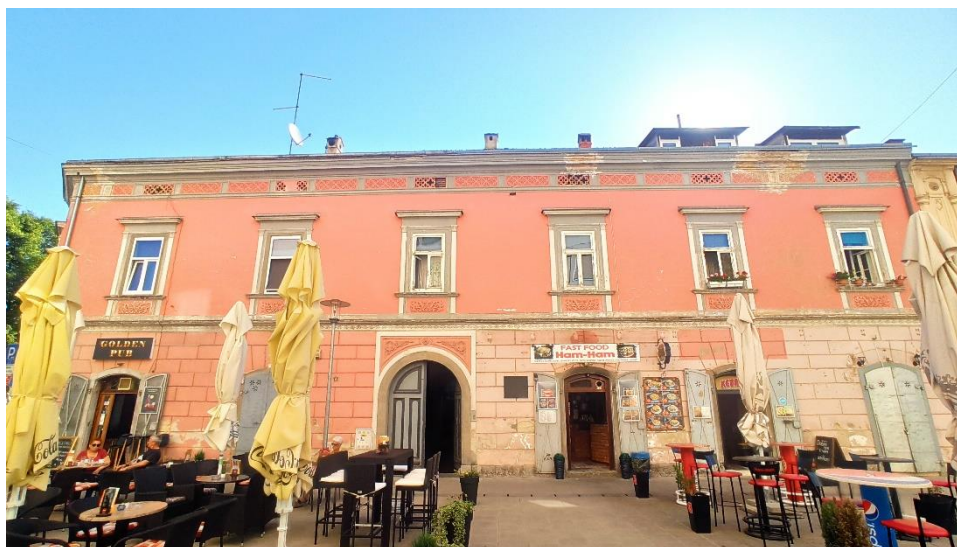
Uglovnica u Šebetićevoj ulici 4 (Kuća Bunete), 1880ih
