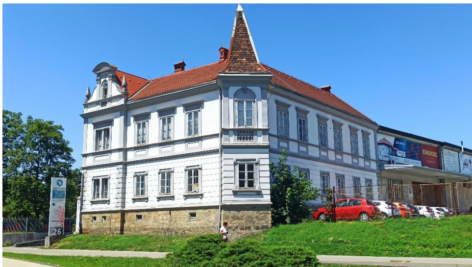
Upravna zgrada Tvornice Ignac Jellenc, 1908., stanje danas (1. 7. 2022.)
