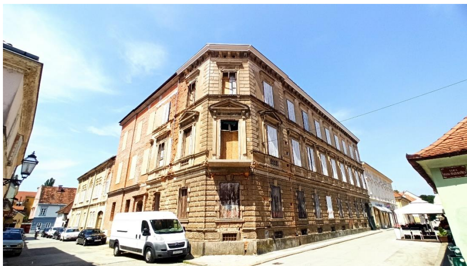
Zgrada Srpske pravoslavne općine u Radićevoj ulici 14, 1882. (29. 6. 2022.)
