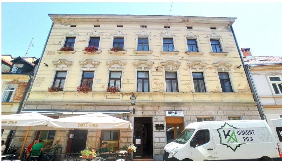
Kuća Strahinjščak u Radićevoj ulici 27, 1902. (29. 6. 2022.)
