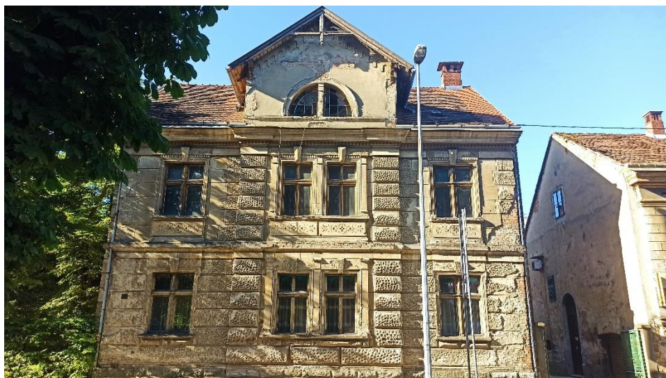
Jednokatnica u Ulici Vladka Mačeka 27 (Kuća Della Tosa), kraj 19. st.
