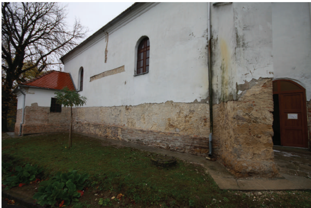
2 Crkva sv. Ane u Podolju, pogled na sjeverno pročelje tijekom istražnih radova (snimila I. Papić)
