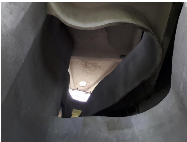
Slika 53. Dijelovi stubišta. Fotografija iz vlastite arhive (2023.).
