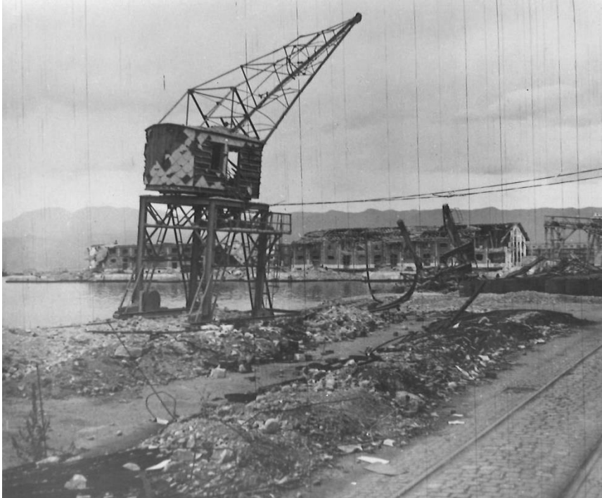
Slika 1. Oštećena lučka infrastruktura
