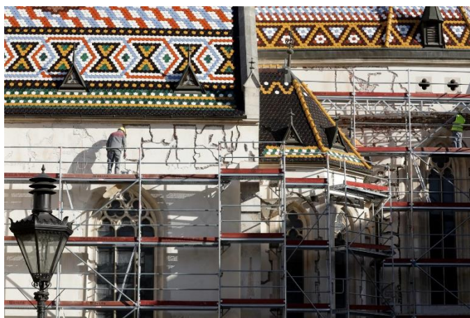
Slika 17. Obnova crkve sv. Marka nakon potresa iz 2020. godine (Izvor: https://www.zagreb.info/vijesti/obnovljena-crkva-sv-marka-simbol-zagreba-ocekuje-blagoslov-ove-nedjelje/571647/ )
