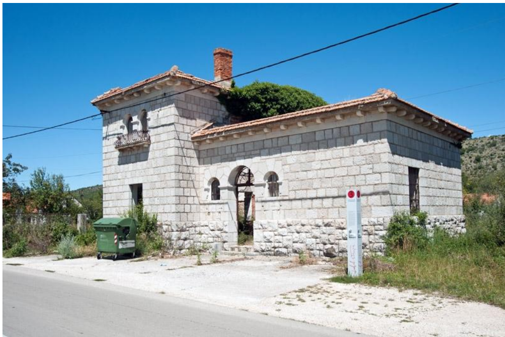
Zgrada Antimalarične stanice
