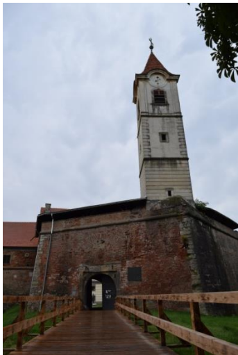
Slika 15. Ulazni bastion utvrde Čakovec, Snimila: Simona Košnjak
