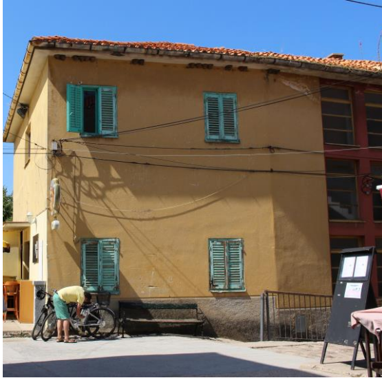
Slika 6.: Današnja zgrada na mjestu Vitezićeva doma
