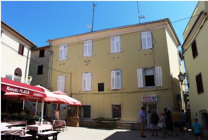
Slika 11.: Zgrada u kojoj se danas nalazi Knjižnica obitelji Vitezić
