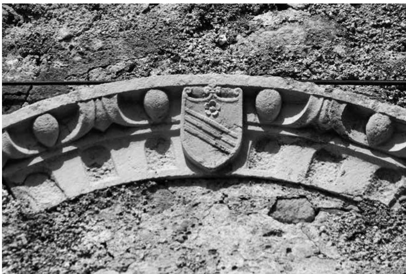
Osor, kuća Schia ili Sbara, detalj (foto: D. Krizmanić) / Osor, Schia or Sbara house, detail
