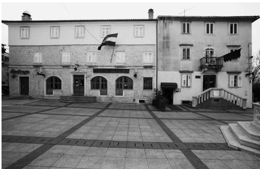
Vela placa, kućni brojevi 6, 7 i 8 (foto: D. Krizmanić) / Vela placa, houses number 6, 7 and 8
