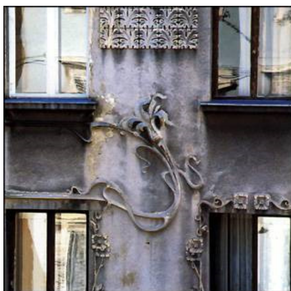
Slika 7. Emilio Ambrosini, detalj Kuće Schittar, 1905., Rijeka
