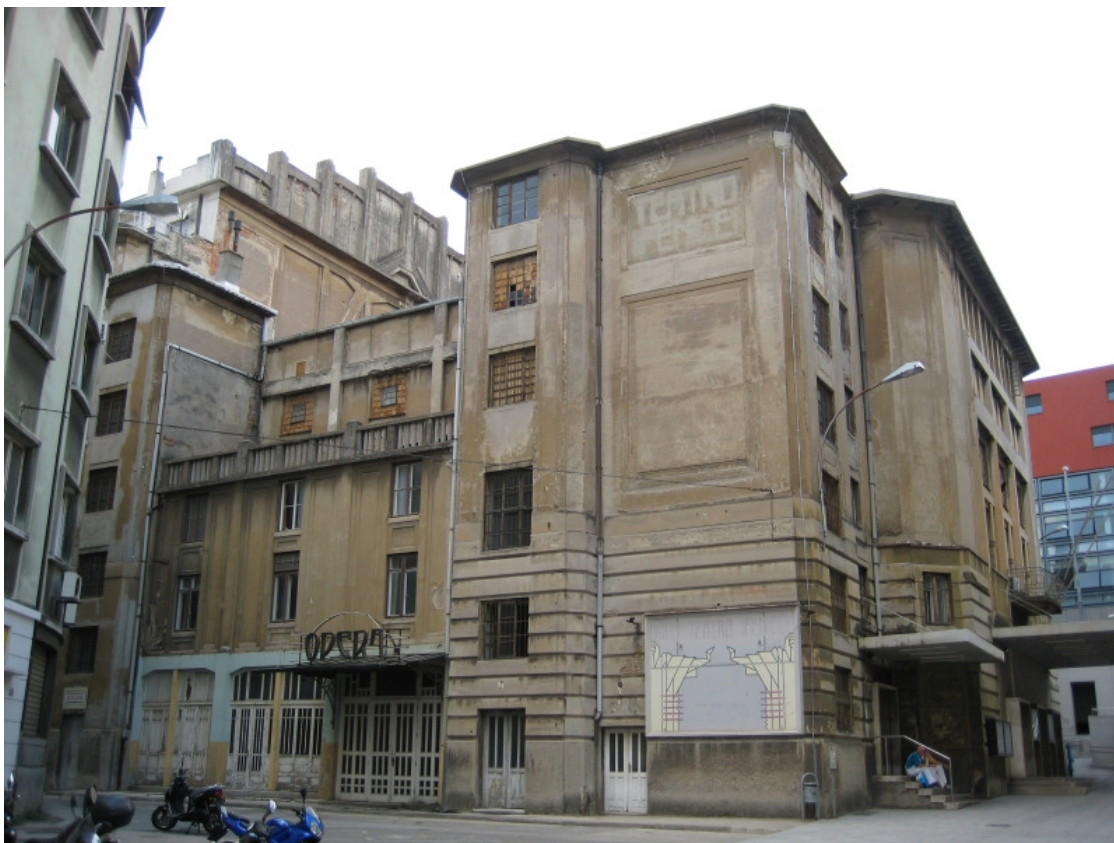
Slika 51. Teatro Fenice, južno i istočno pročelje
