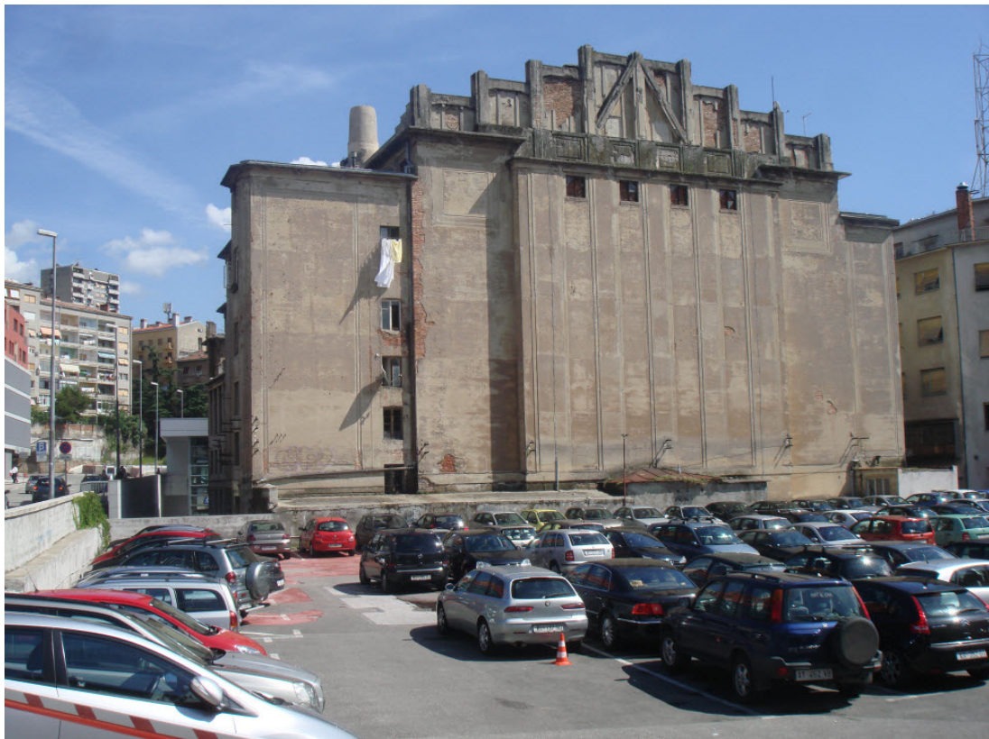
Slika 52. Teatro Fenice, stražnje (zapadno pročelje)
