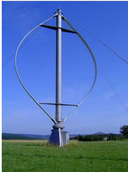
Slika 2.2. Darrieusova turbina.
