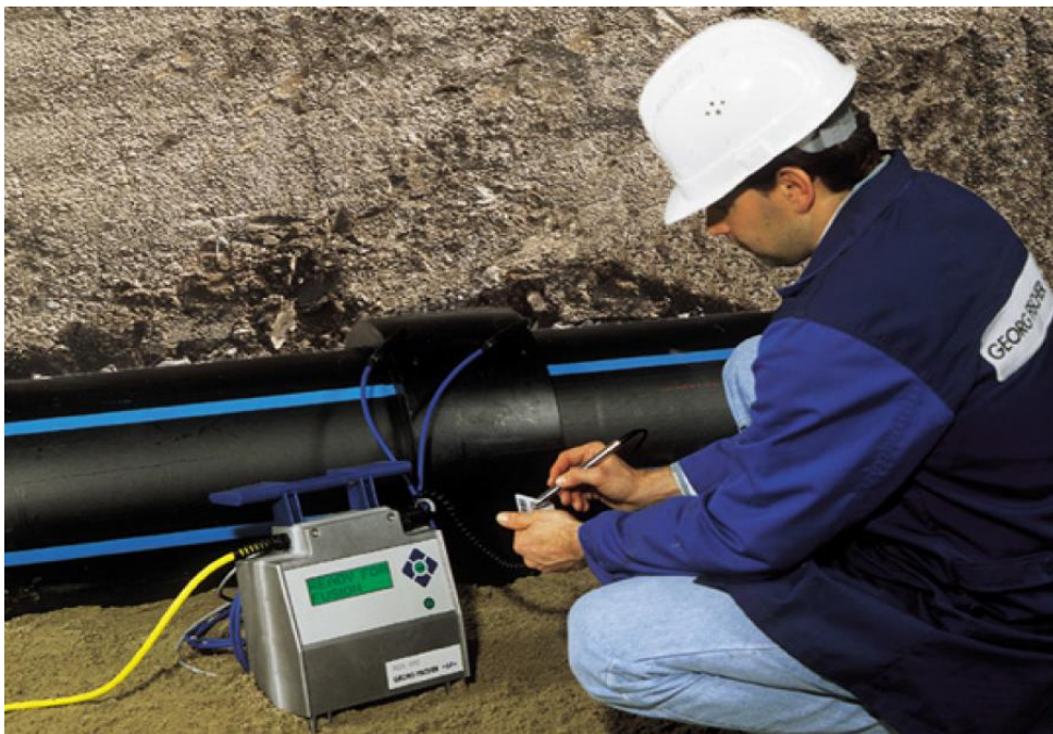
Slika 4.1. Elektrofuzijsko zavarivanje[8]
