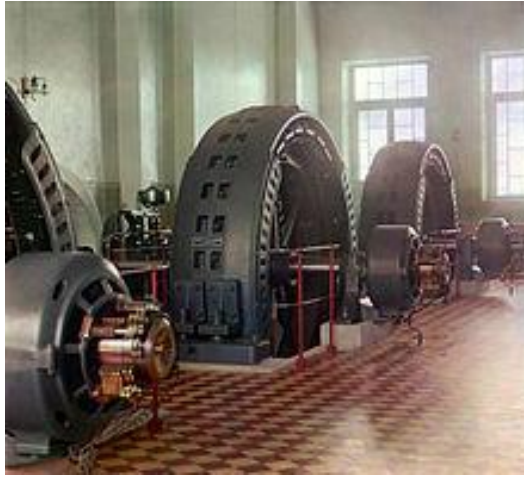
Slika 2.10. Izmjenični generator
