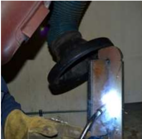
Slika 2.1. Zavarivanje MAG postupkom [8]
