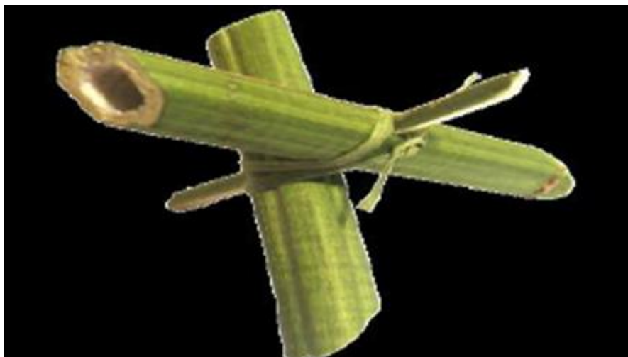
Slika 4.3. Vezivanje armature prirodnim vlaknima [12]
