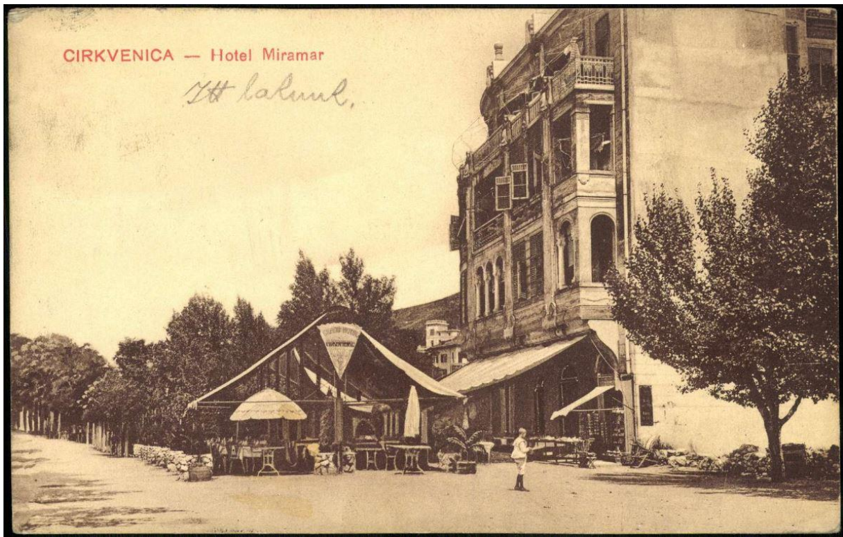
Slika 55. Hotel Miramare, početak Kupališnog perivoja, vidljiva natkrivena terasa, (Izvor: http://www.lokalpatrioti-rijeka.com/forum/viewtopic.php?f=205&t=1615&start=45 , pristupljeno 3.8.2017.)
