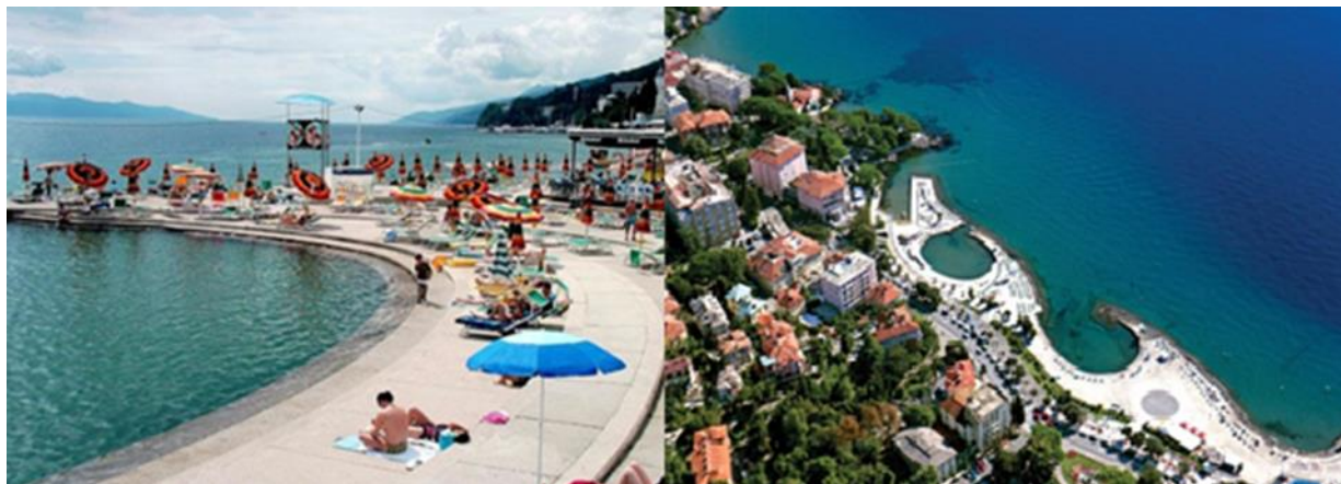
Slika 10. Primjer betonske plaže u središtu grada Opatije
