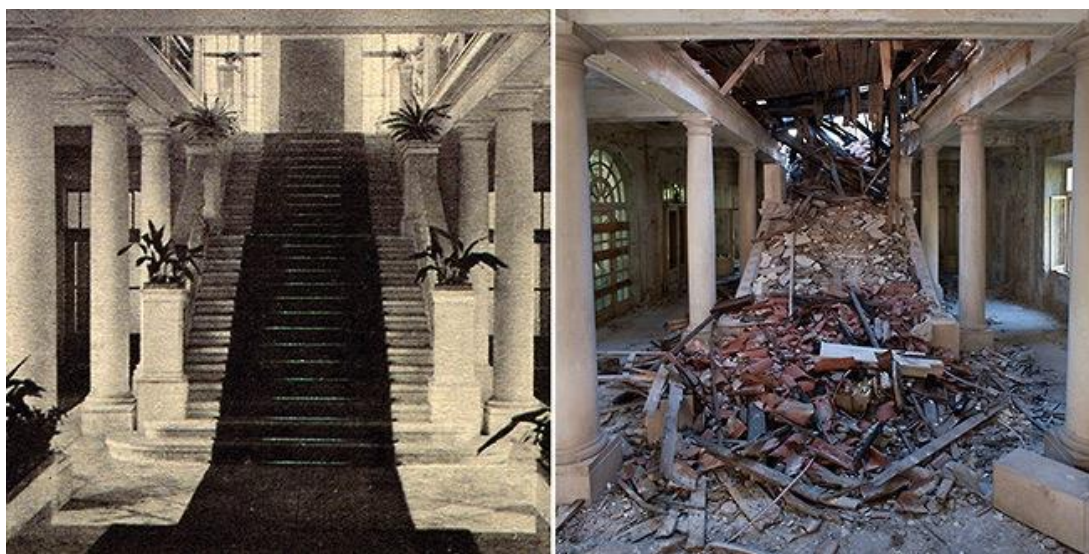
Slike 43. Izgled glavnog stubišta Hotela Grand . Stupovi s kapitelima toskanskog reda sačuvani i danas. (lijevo) Izgled 1920-ih godina i (desno) 2016. g.
