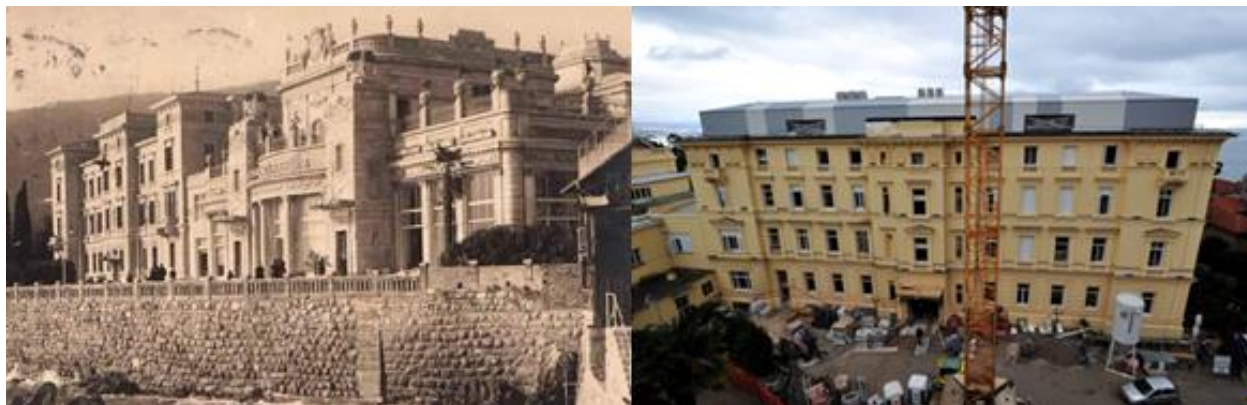
Slika 6. Hotel Kvarner početkom 20-og st. i tijekom nadogradnje 2014.g.
