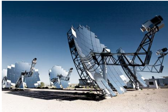
Sl.3.16. Primjer postrojenja parabolično tanjurastih kolektora [24]
