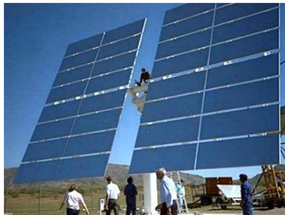
Sl. 3.11. Jedan od heliostata u instalaciji [18]
