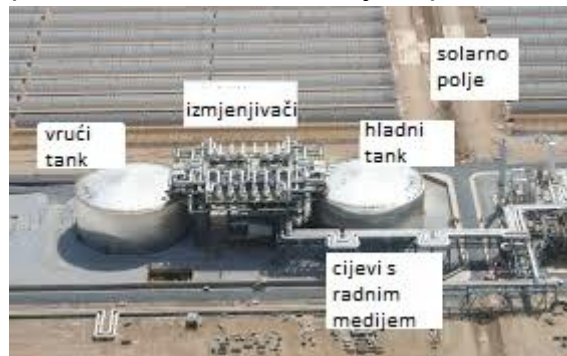
Sl. 4.2. Hladni i vrući tank rastaljene soli integriran u solarnu termoelektranu s paraboličnim žljebastim kolektorima [32]
