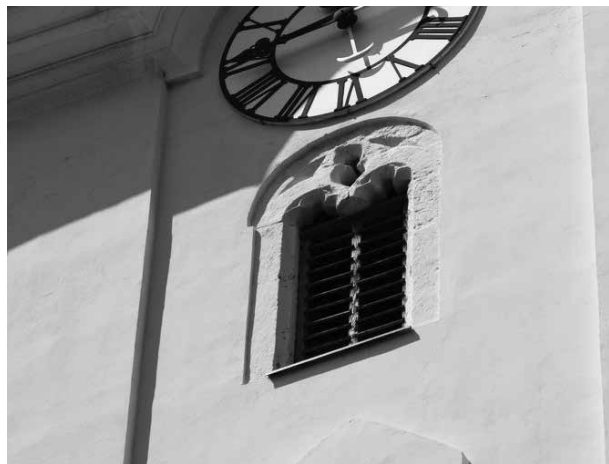
8. Kloštar Ivanić, crkva sv. Marije, zvonik, šesti kat, istočno pročelje, kasnogotičko mrežište (foto: M. Cepetić Rogić) / Kloštar Ivanić, church of St Mary, belfry, sixth floor, east front, late Gothic tracery (photo: M. Cepetić Rogić)
