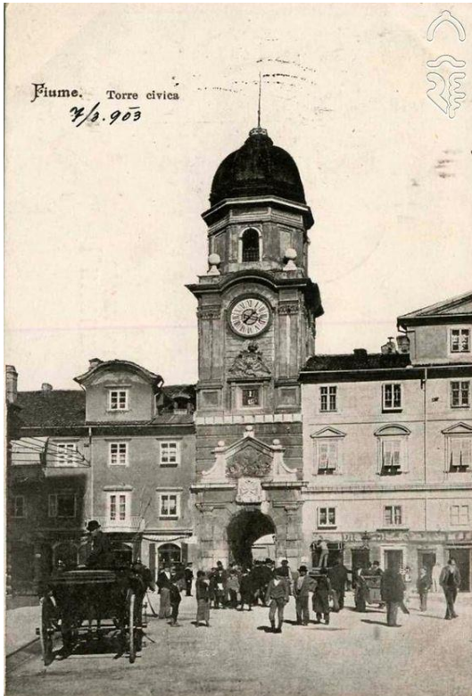
Fig. 17. Torre civica prima del 1906
