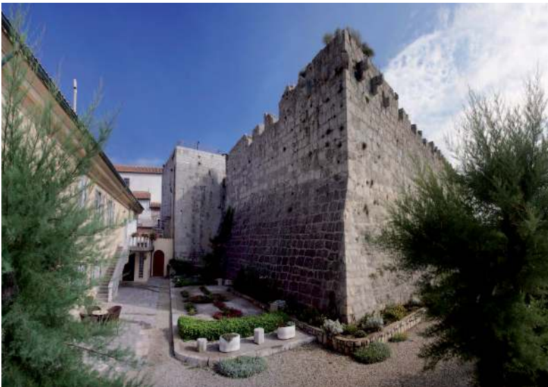
Kaštel u Krku, pogled iz vrta biskupske palače (foto D. B.)
