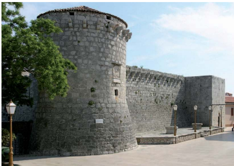
Grad Krk, pogled s Kamplina na gradski kaštel (foto D. K.)
