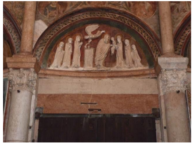
Fig. 14 Parma, Battistero, interno, Particolare del sistema degli architravi e della cornice della lunetta del Portale della Presentazione al Tempio.
