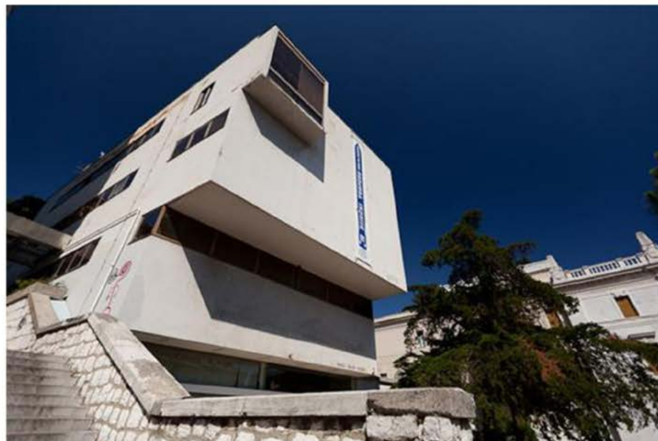
Muzeja grada Rijeke, pročelje ( http://www.visitrijeka.hr/Sto_vidjeti/Muzeji_i_zbirke/Muzej_grada_Rijeke , 3.12.2014.)
