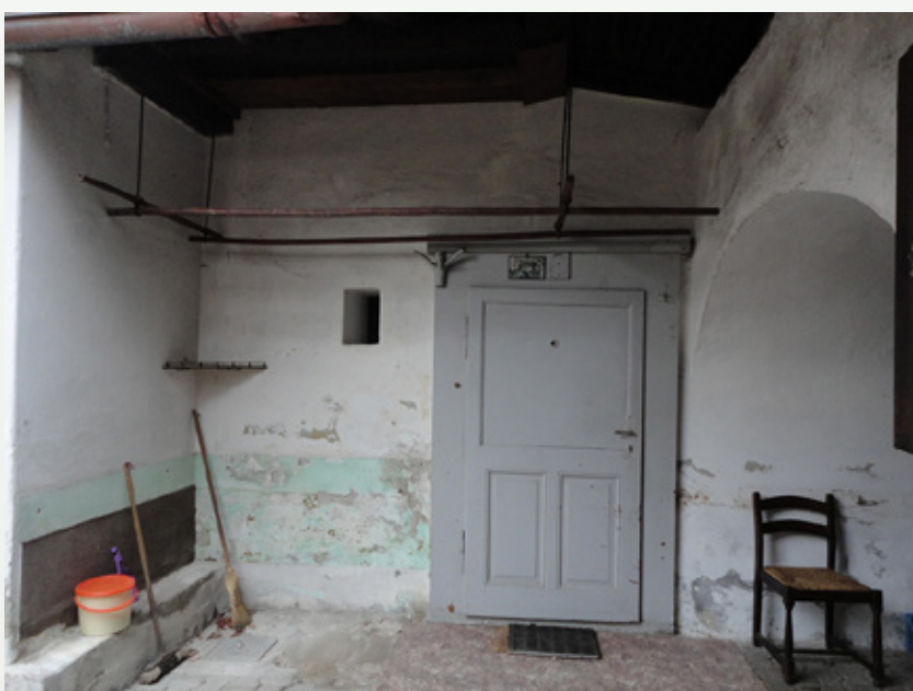
Plečnikova kuća, stanje prije obnove
