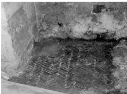
Slika 12. Pod od opeke u prostoriji zapadnog krila, riblja kost
