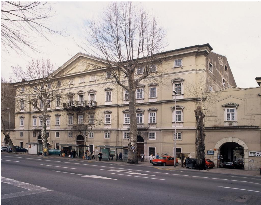
Slika 3. Upravna zgrada bivše rafinerije Šećera
