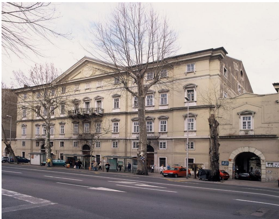
Slika 3. Upravna zgrada bivše rafinerije Šećera
