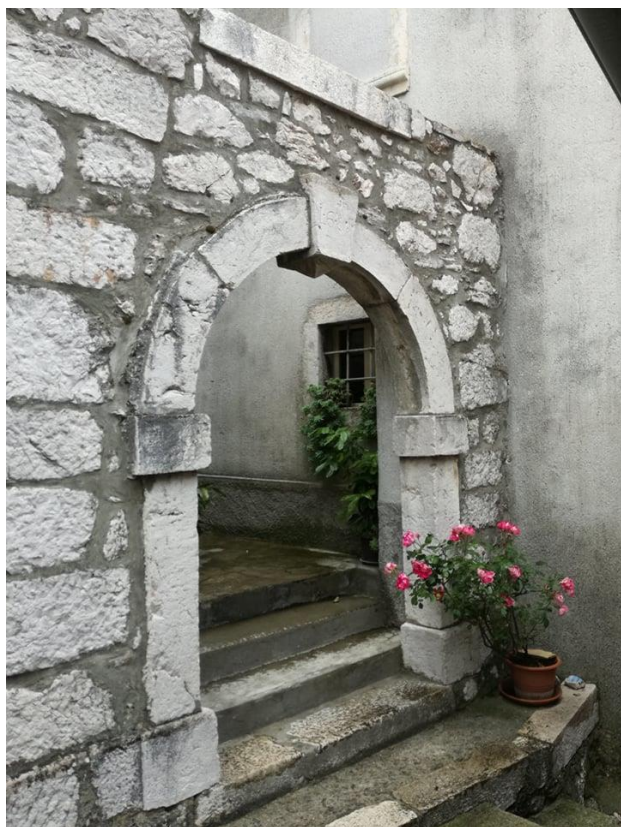
Slika 24. Portal Kučićeve kuće, snimila: Iva Kuljiš, 2019.
