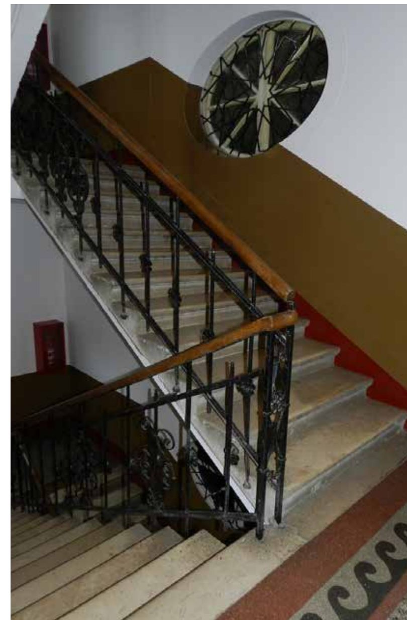
7 „Turska kuća“, Rijeka, stubište
