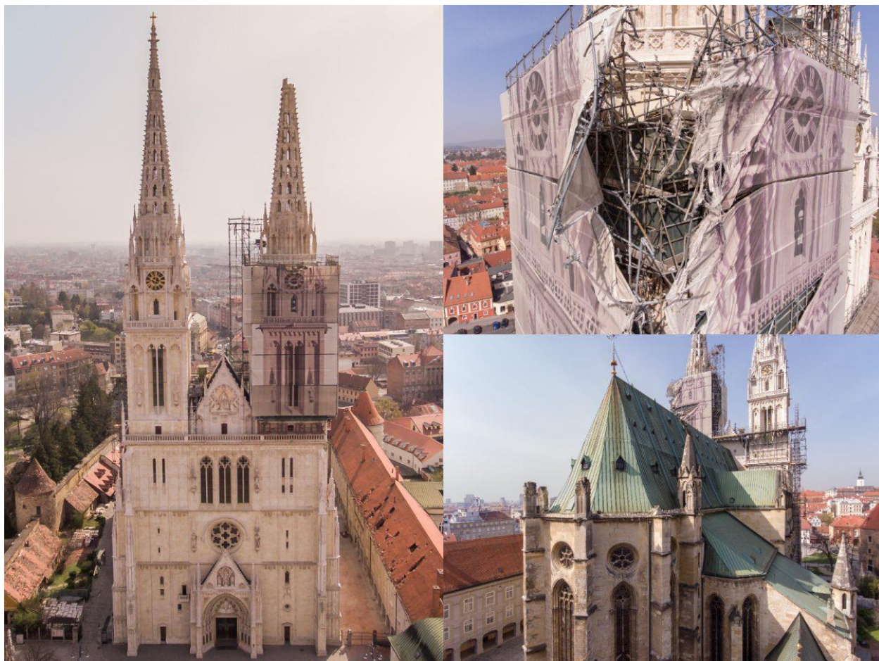
Slika 19: Oštećenja katedrale gledana iz zraka
