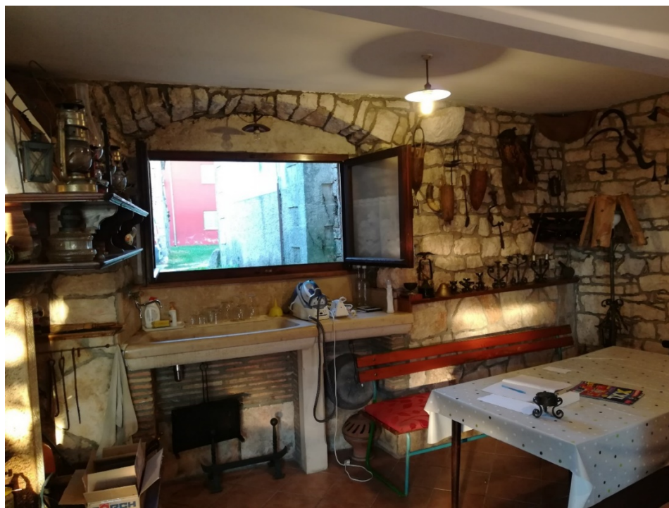
Sl. 20. Nekadašnji prolaz u sklopu zidina zaključen plitkim segmentnim lukom, prolaz je naknadno reduciran na veličinu prozorskog otvora
