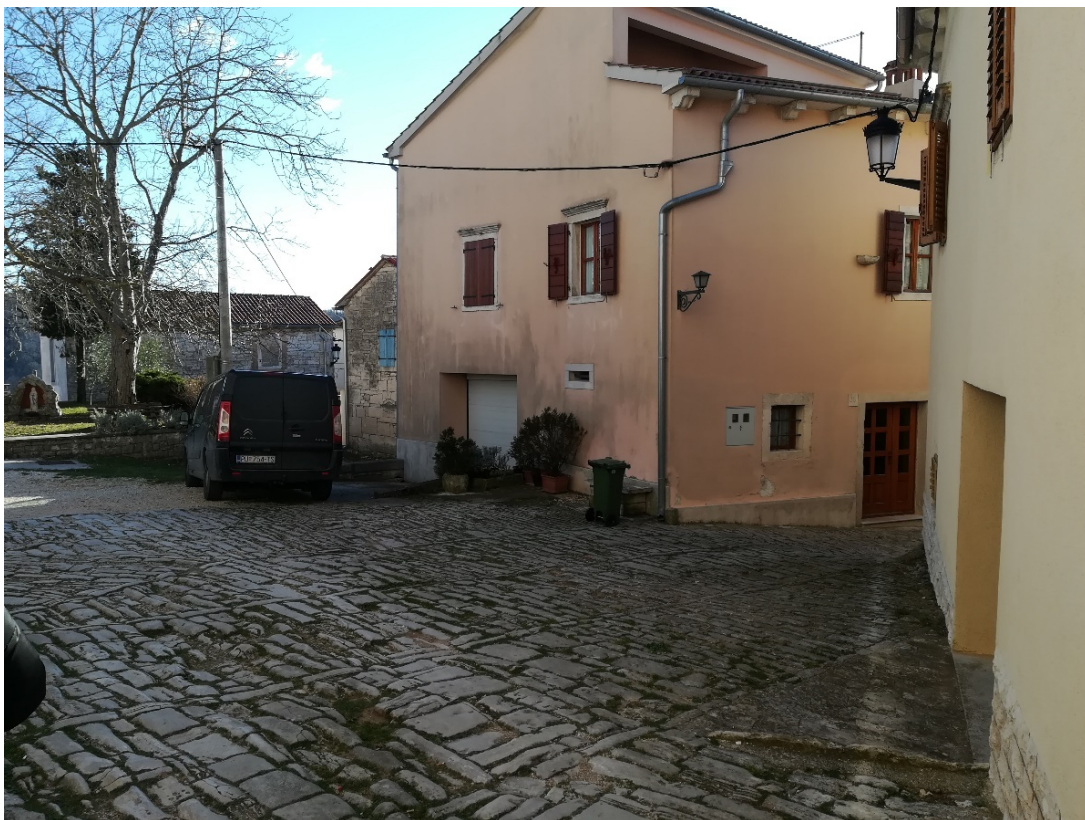
Sl. 35. Barokna kuća na trgu ispred župne crkve – danas s fasadom, garažnim vratima i izduženim prozorima konobe
