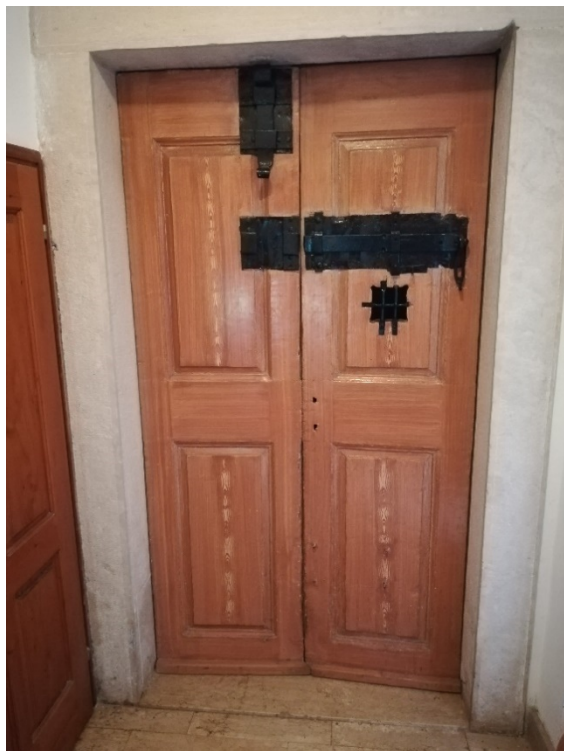
Sl. 18. Vrata nekadašnjeg zatvora s očuvanim dijelom originalnih okova
