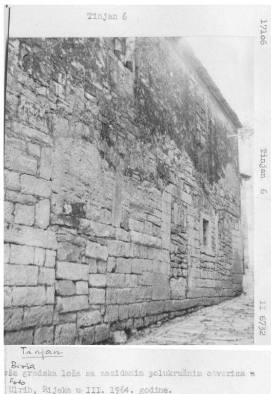
Sl. 5. Gradska loža sa zazidanim polukružnim otvorima, Konzervatorski odjel u Rijeci, 1964.
