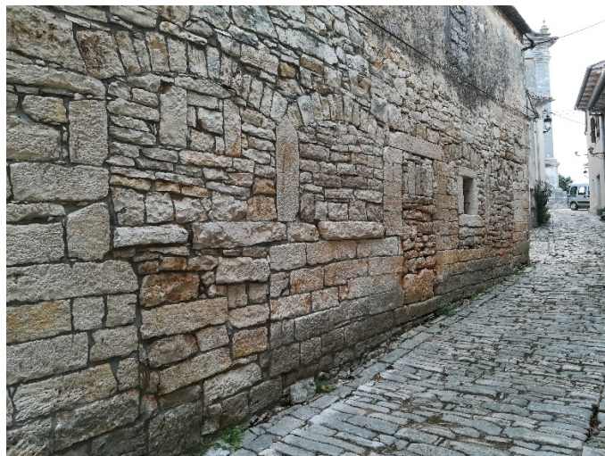
Sl. 6. Gradska loža sa zazidanim polukružnim otvorima, 2020.
